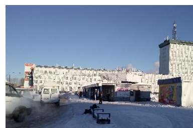
Здание автовокзала и разворотная площадка Фото: Ольга Губина / ООО «ЦЕНТР ЛАБ»
