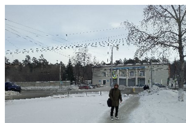
Здание пожарной части Фото: Ольга Губина / ООО «ЦЕНТР ЛАБ»
